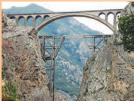
(ب) پل پورسک
